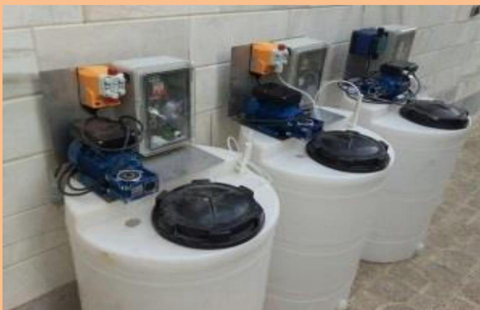
\*پکیج ازن: با استفاده از گاز ازن در ضد عفونی آب و فاضلاب استفاده می شود.
